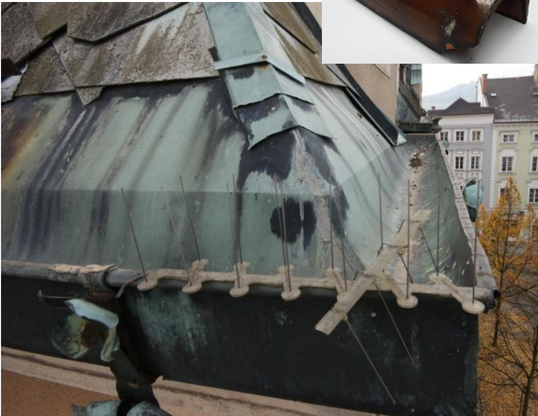
VÝKRES DOPLNĚN DETAILEM STÁVAJÍCÍHO PROVEDENÍ NADŘÍMSOVÉHO ŽLABU JAKO TVAROVÉHO VZORU PRO NOVÉ ŘEŠENÍ A TYPEM PŮVODNÍHO HŘEBENÁČE
