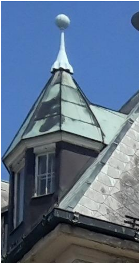
STŘECHA VIKÝŘE PSV Č. 32 BUDE PROVEDENA PODLE VZORU PSV Č. 31 ( KONKÁVNÍ JEHLAN, ROZMÍSTĚNÍ FALCŮ, ODVĚTRÁNÍ PATOU FIÁLY A HŘEBENEM )
