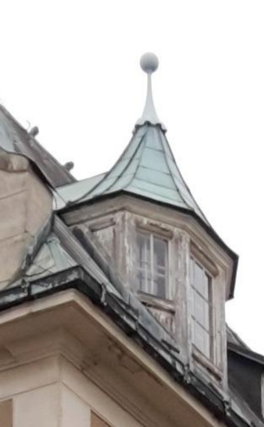
STŘECHA VIKÝŘE S FIÁLOU PSV Č. 31 JAKO VZOR PRO REPLIKU BUDE DOPLNĚN HŘEBENOVÝM ODVĚTRÁNÍM A VĚTRACÍM PRSTENCEM POD ZVEDNUTOU FIÁLOU
